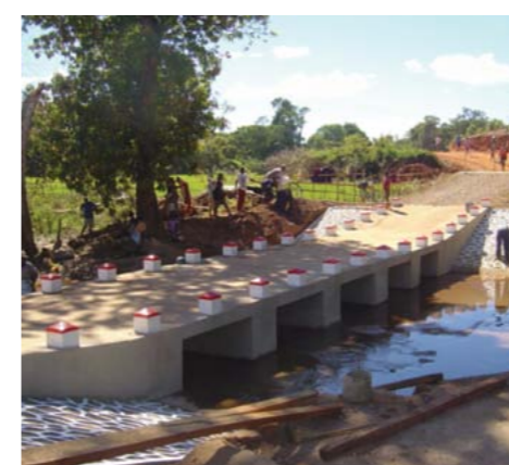
Pont radier à Ibora Antsohihy
