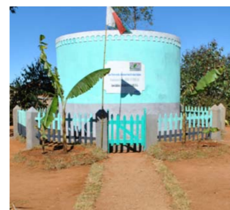
Château d'eau à Ankorondrano Manjakandriana
